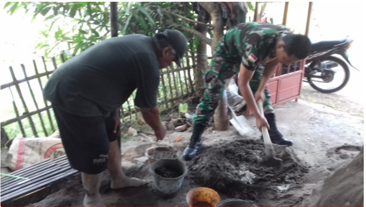
Babinsa Ceper Bantu Warga Renovasi Rumah Binaannya
